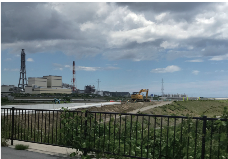
석탄가스화복합발전(IGCC) 현장 가는 길 일본 후쿠시마(福島), 필자 촬영(2018. 6. 1)
