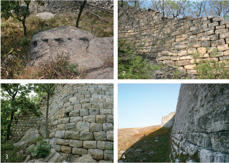
사진6 | 고구려 석성 기초부 조성방식(©양시은) 1. 착암기초법(위패산성, 2007년) 2. 버팀축조법(고검지산성, 2008년) 3. 그랭이기법(위패산성, 2007년) 4. 들어쌓기(백암성, 2007년)
