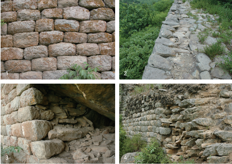
사진7 | 장하 성산산성의 성벽 축조방식(©양시은, 2007년) 1. 성벽의 6합 구조 2. 썩기꼴 돌을 이용한 겹쌓기 3. 썩기꼴 돌과 북꼴 돌의 결합 4. 썩기꼴 돌과 북꼴 돌의 결합
