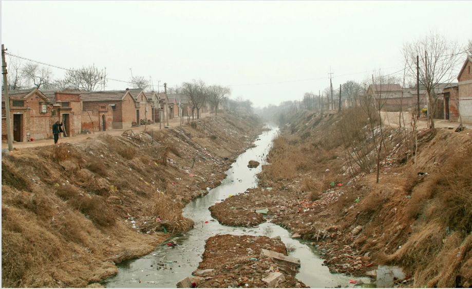
물이 말라서 황폐해진 대운하 린칭 구간
