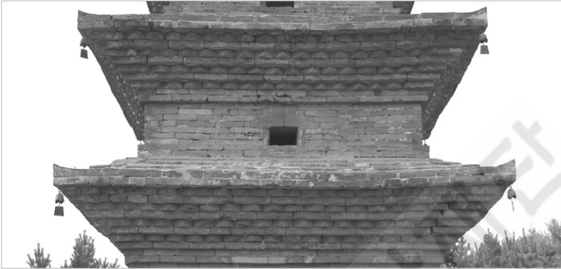
〈사진 3〉 영광탑 옥개부 처마 내쌓기 수법(남면 1층과 2층 옥개부)
